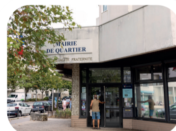
Mairie de quartier Mansart 2, boulevard Mansart
